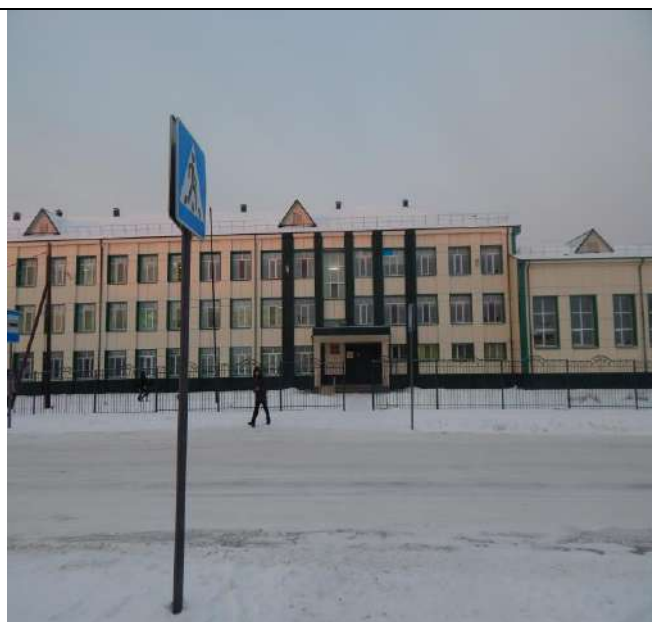
Подъезд к школе
